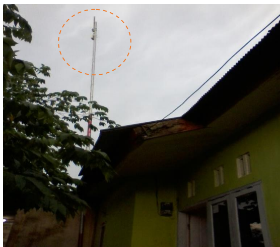
Gambar 3. Pemasangan Antena Omni
